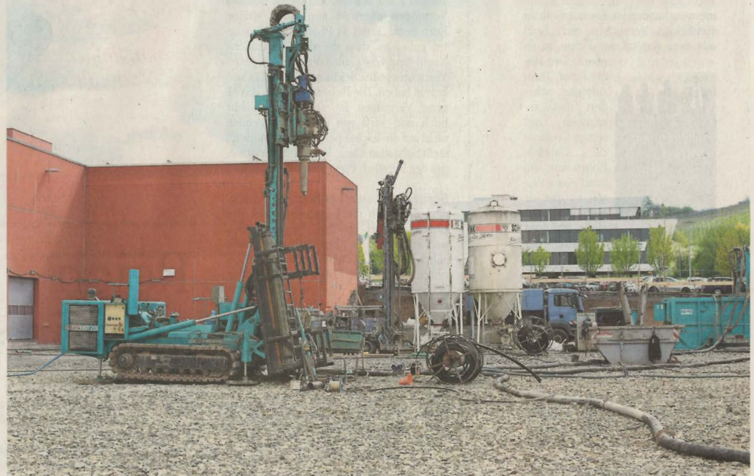
48 Meter geht es abwärts in die Erde, um an die Wärmeenergie zu gelangen, die für den derzeit entstehenden Erweiterungsbau genutzt werden soll. Insgesamt zehn Millionen Euro werden in den Ausbau der Logistikhalle investiert.
