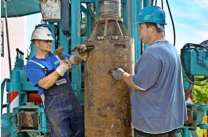
Spezialisten bergen in Zumhof Relikte der Erdwärmebohrungen. Foto:
