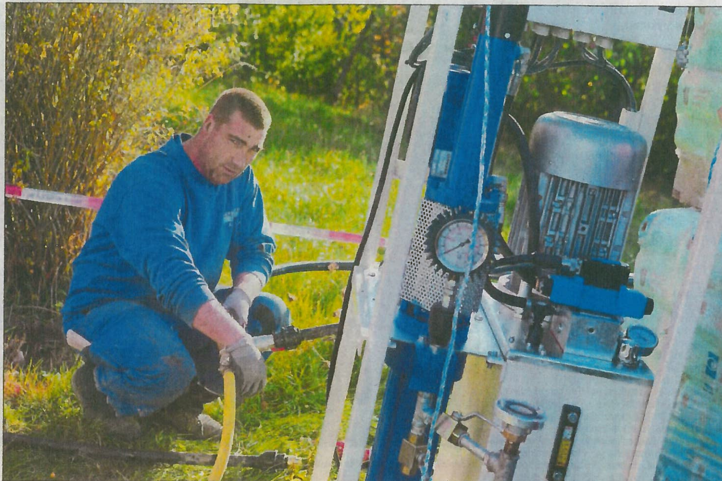
Vor Ort in Zumhof: Alexander Bax arbeitet an der Verpressanlage für den Zement.
