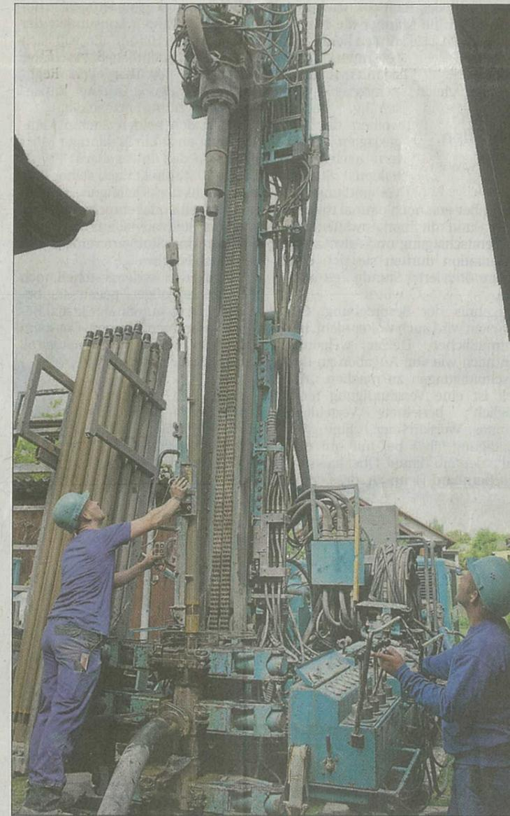
Um die Wärme der Erde anzuzapfen, bohrt eine Spezialfirma zwei 150 Meter tiefe Löcher in Offerdingens Boden.
