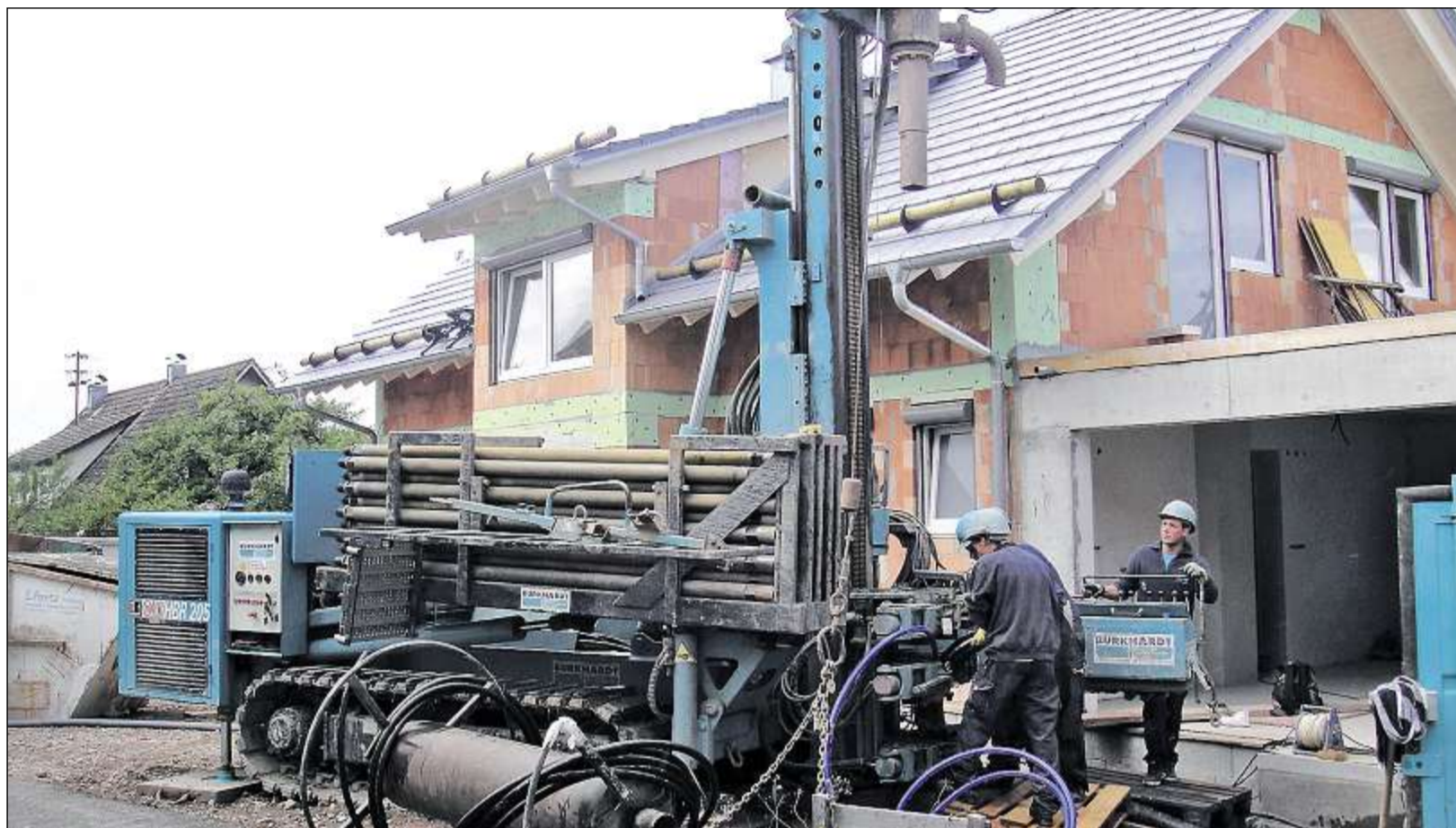
WÄRME AUS DER TIEFE: Erdwärmehohrungen versprechen preisgünstige Heizenergie. Anders als in Staufen und Leonberg sind nach Auskunft des Landratsamtes bei Bohrungen im Rheinkies und Schwarzwaldgestein keine Gebäudeschäden zu befürchten. Foto: Burkhardt
