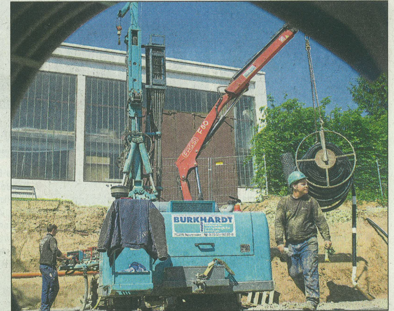
Erdbohrungen laufen zurzeit bei KERN-WOHNBAU in der Hackstraße in Ludwigsburg-Hoheneck. Bilder: Holm Wolschendorf
