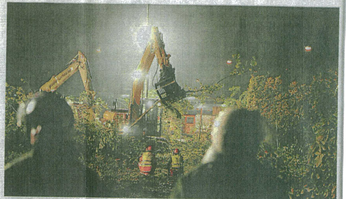
S 21-Gegner haben die Bauarbeiter, die im Stuttgarter Schlossgarten mit dem Abholzen der Bäume begonnen haben, umgehend als „Baummörder“ beschimpft.
