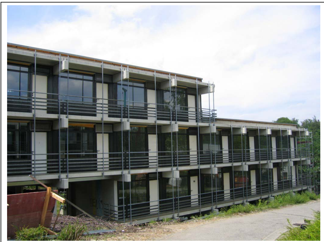
Abb. 1. Beginn der Sanierungsarbeiten an einem Wohnblock der Anlage West II
